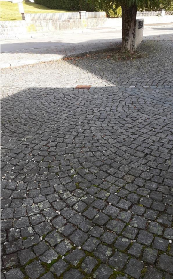
Eingangsbereich : - mit Abfluss
